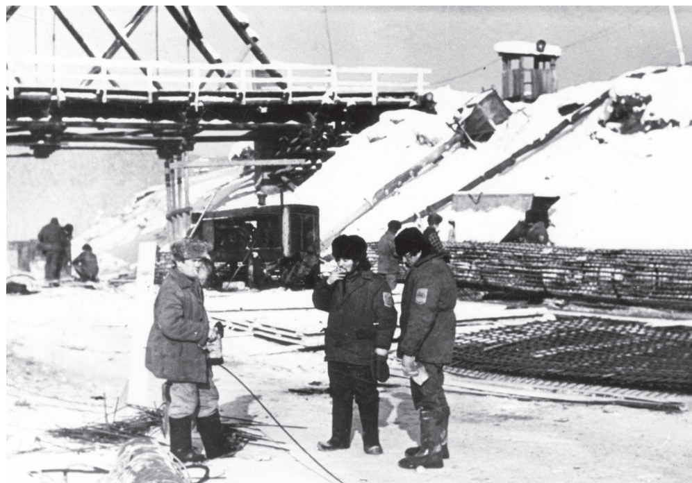
Николай Бондарь принимал участие в монтаже мостов через Лену, Куту
