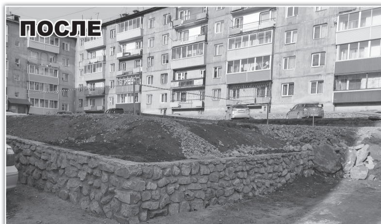
Подготовлен участок для установки детской площадки: сделана подпорная стенка, выровнен рельеф, залит бетон. Малые формы будут установлены в следующем году с наступлением тепла. Предварительно бетон покроют резиновой крошкой. Вокруг произведут озеленение
