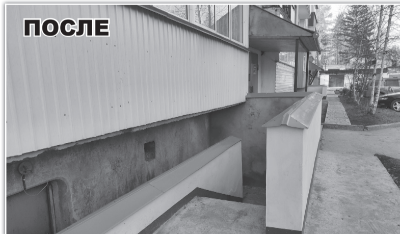
За счет гранта ИНК ТСЖ «Олимп» отремонтировал десять входных групп в подъезды и все входы в подвалы
